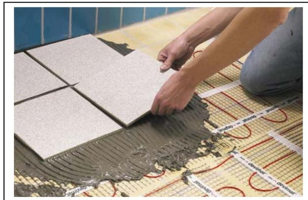
Рис. 3. Монтаж нагревательного мата **Devimat™ DTIF** в ванной комнате на старую плитку.
